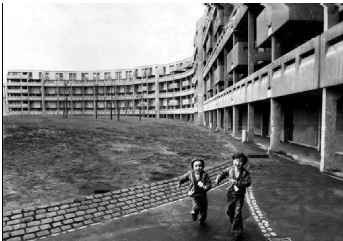
Hulme Crescents, Manchester, od modernistické firmy Wilson & Womersley, kdysi nejnefunkčnejší sídliště v Evropě, zbouráno.
