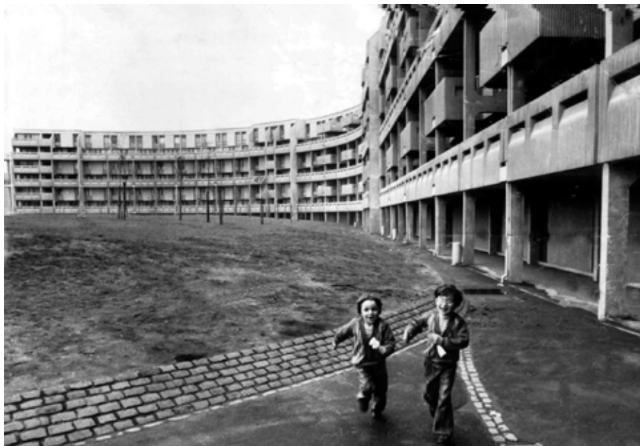
Hulme Crescents, Manchester, od modernistické firmy Wilson & Womersley, kdysi nejnefunkčnější sídliště v Evropě, zbouráno.
