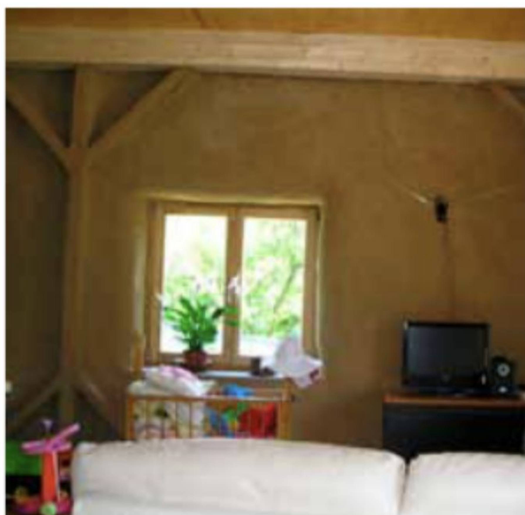
Obr. 6) Kombinace dřeva a hlíny v novostavbách.
