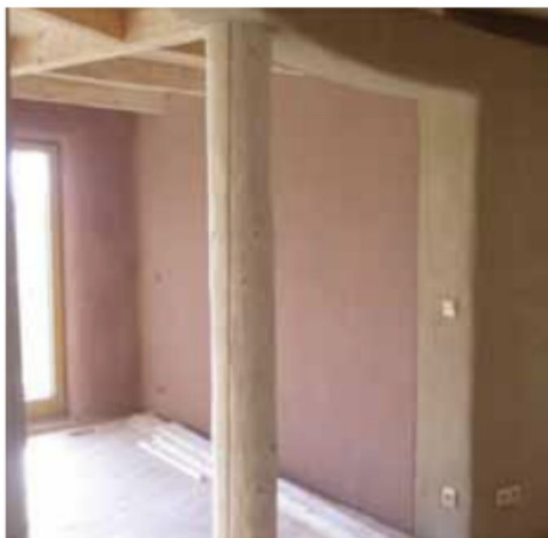
Obr. 5) Kombinace dřeva a hlíny v současném stavitelství.
